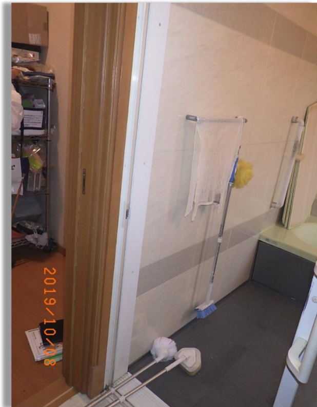
■現状写真■ (工事施工前)
